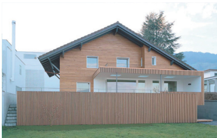
Saniertes Chalet: Eigenständiger Baukörper zwischen dominanten Nachbarhäusern
