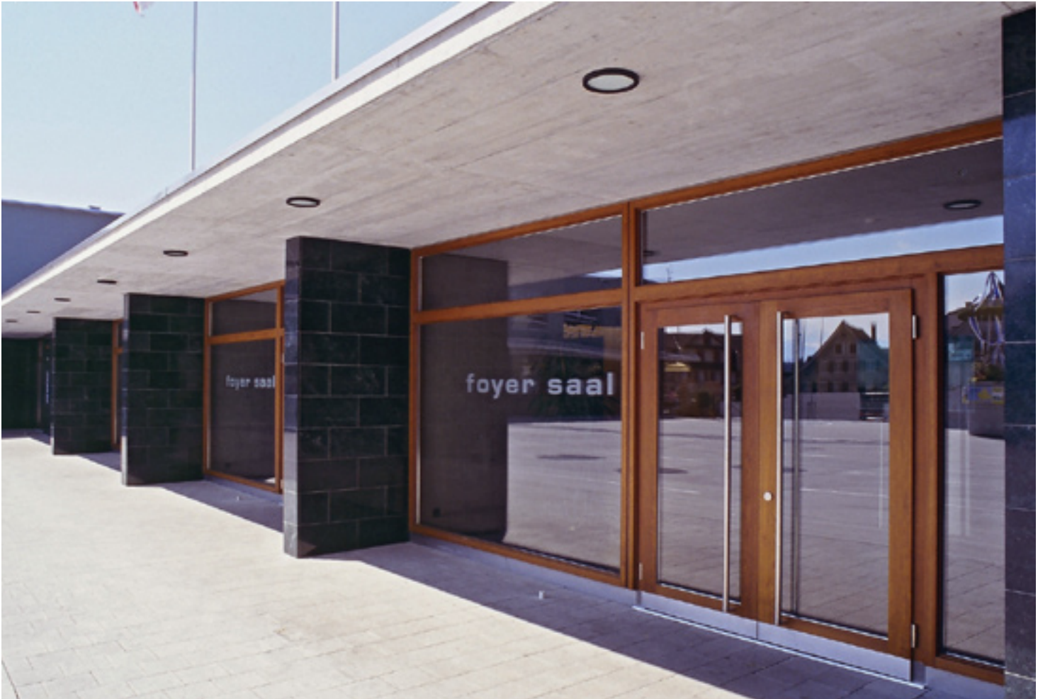
Eingangsfassade zum Platz
